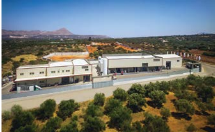
Κεντρικές Εγκαταστάσεις στα Χανιά της Κρήτης (Περιοχή Καθιανά, Ακρωτηρίου)
