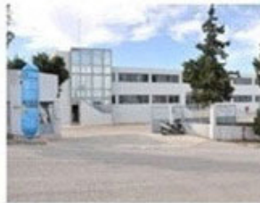
Κέντρο Διανομής Κεντρικής & Ανατολικής Κρήτης (ΒΙ.ΠΕ. Ηρακλείου, Κρήτη)
